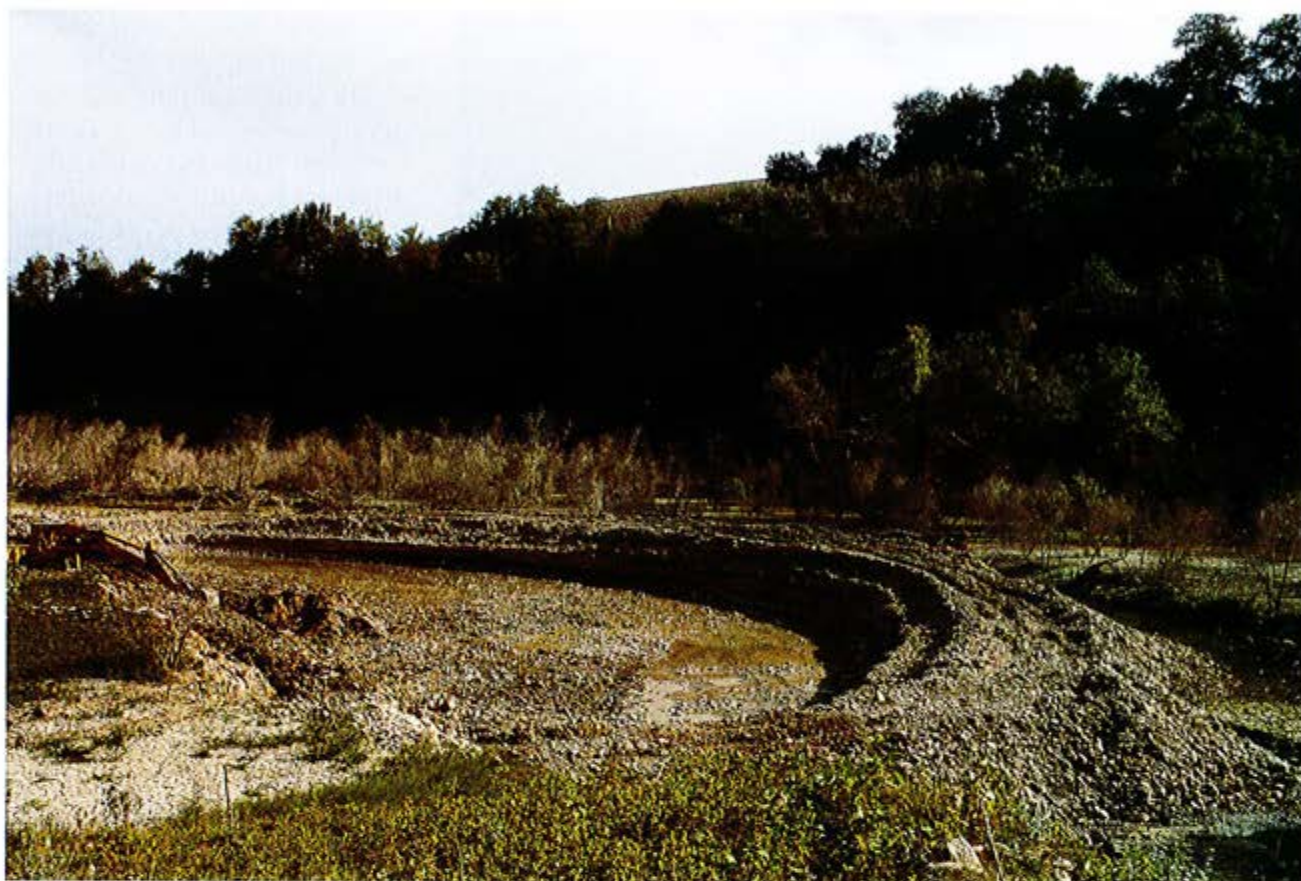
La costruzione di un piccolo lago all'interno dell'invaso utilizzato per la sopravvivenza dei pesci
