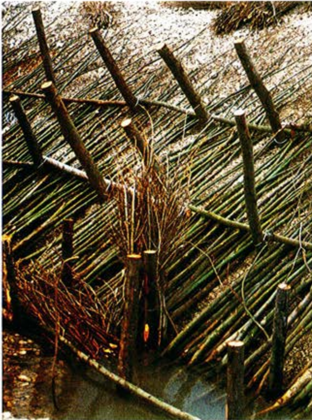
Intervento di ingegneria naturalistica. Foto David Belfiori
