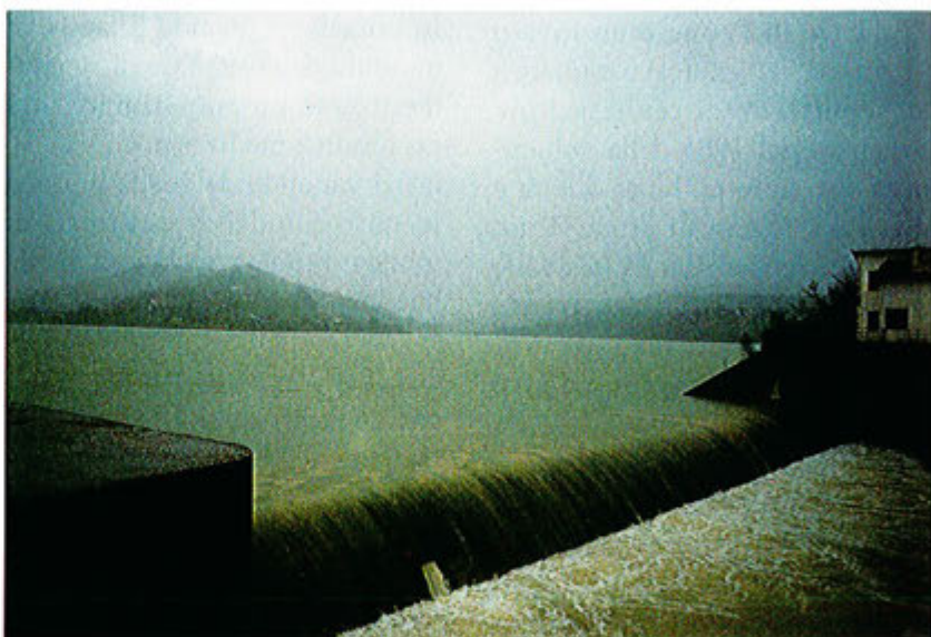
Tracimazione dell'acqua allo sfioratore: piena del 10 aprile 1992. Foto Fernando Di Fabrizio
