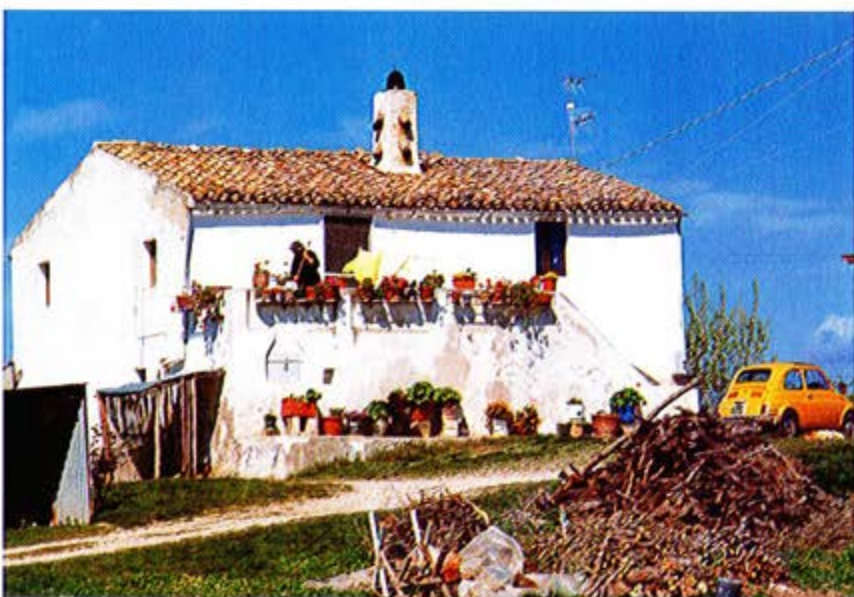
Piccola abitazione in contrada Favaro.
