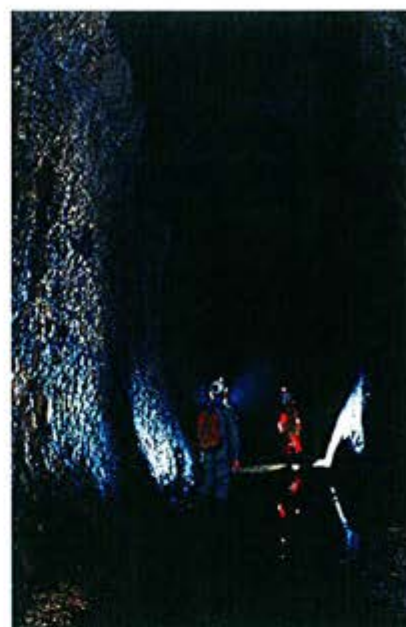
La parte intermedia della "Galleria Torlonia" scavata nel calcare. Si evidenzia, nella parte superiore, l'originale tracciato della galleria romana sovrapposto a quello successivo della metà dell'Ottocento.
