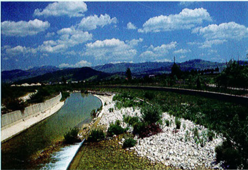
Il corso del fiume Sangro nei pressi di Castel di Sangro. Le foto sono state realizzate nello stesso punto e nel medesimo istante: in alto l'immagine ritrae il tratto a monte della strada, l'altra il tratto a valle della stessa strada. Foto Mario Pellegrini
