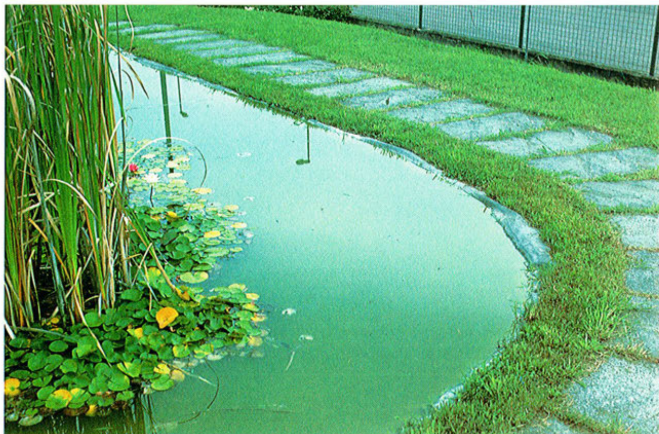
Uno stagno artificiale allestito con telo multistrato in PVC, il cui bordo è stato mimetizzato con zolle d'erba e lastre di pietra. Foto Vincenzo Feni
