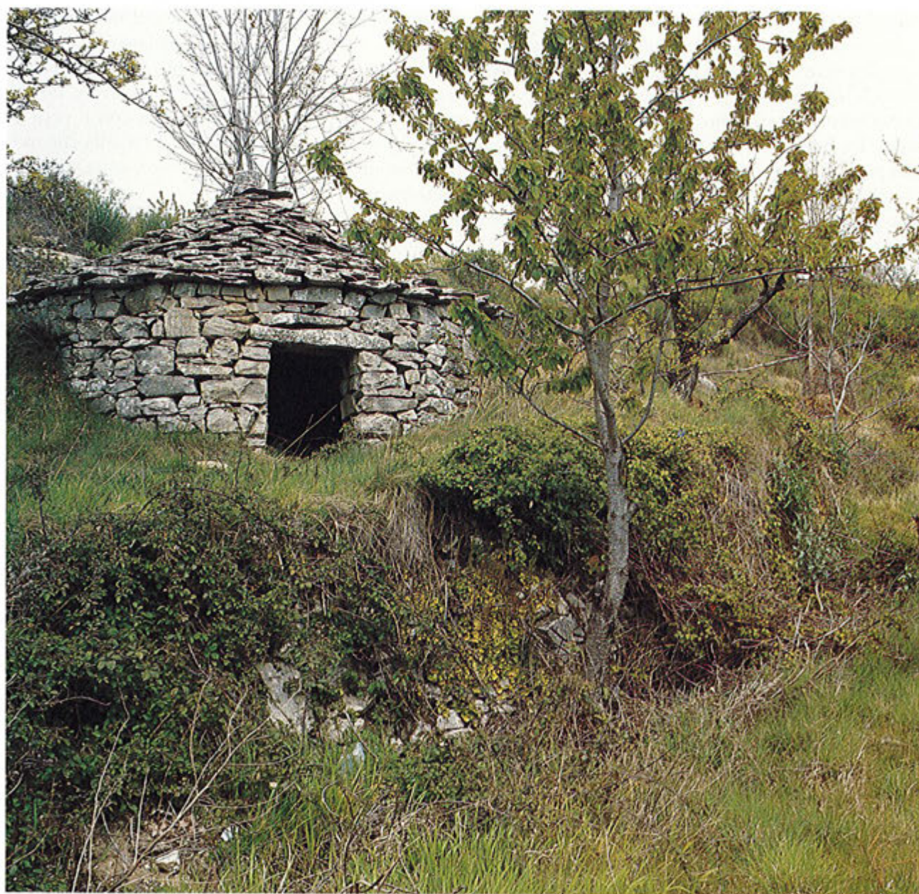
Lungo il percorso, una tradizionale costruzione di pietra a secco con copertura "a falsa volta" detta localmente "casarella".
